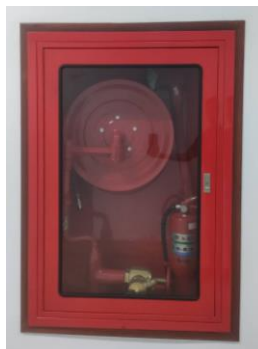
ภาพที่ 3-4 ถังดับเพลิงชนิดผงเคมี (Dry chemical powder)
